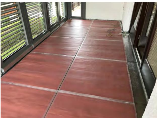
Die elektrische Fußbodenheizung mit Kohlenstofffasern ist ein patentiertes System mit nur 4mm Dicke, die in Standard oder maßgeschneiderten Modulen sowohl hinsichtlich Leistung als auch hinsichtlich der Geometrie in Einzelstücken je mit einer maximalen Oberfläche von 25 m<sup>2</sup> geliefert werden kann.
